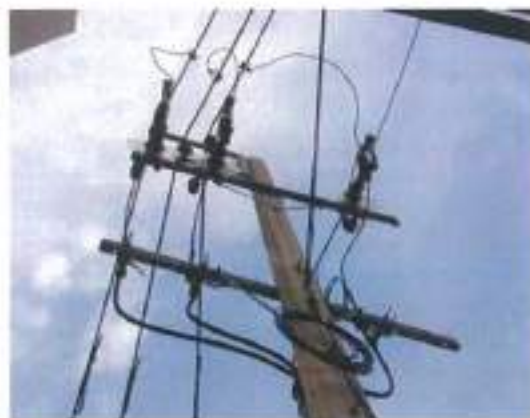
ชุดอุปกรณ์ปลด-สับด้านแรงสูง
