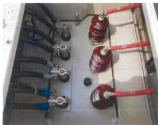
สวิตช์ตัวนำของแรงดันสูง-ต่ำ
