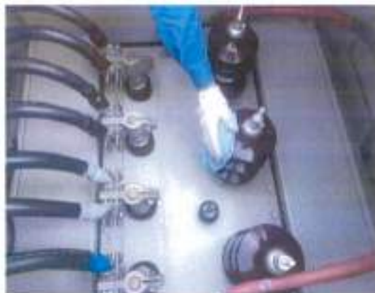
ทำความสะอาด Bushing ด้านแรงสูง
