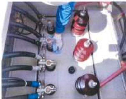
ทำตรวจสอบ Bushing ด้านแรงต่ำ
