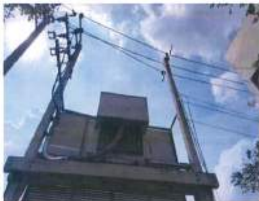
ลักษณะการติดตั้งฉนวนแปลงไฟฟ้า
