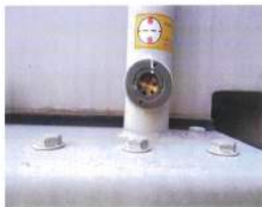
ตัววัดระดับน้ำมัน : Oil Level Indicator
