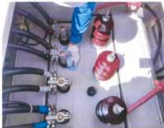
ทำการตรวจสอบ Bushing ด้านแรงต่ำ
