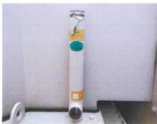
พีอีระดับน้ำมัน : Oil Level Indicator
