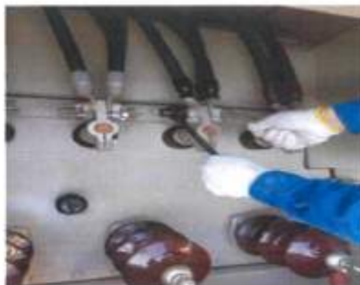
ขันขันขันขันสายไฟฟ้าด้านแรงต่ำ
