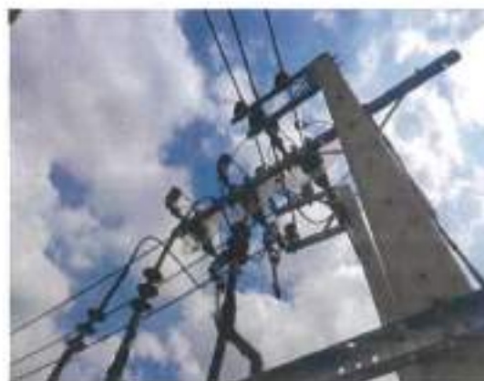
อุปกรณ์ป้องกันฟ้าผ่าแรงสูง : Lightning Arrester
