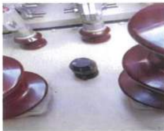
ตำแหน่งที่เปลี่ยนแรงดัน : Tap Changer
