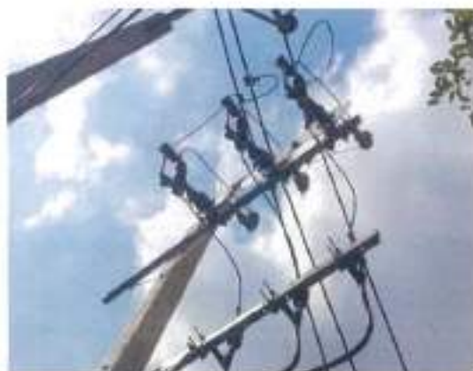
ชุดอุปกรณ์แปลง-สับตัวแรงสูง
