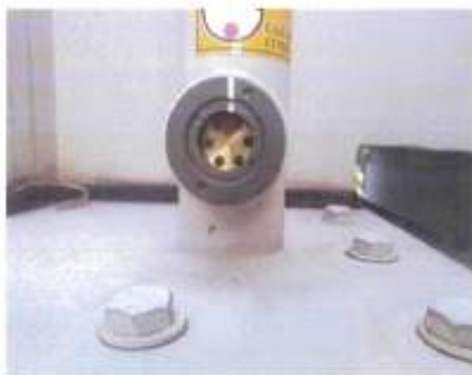
ตัวชี้วัดระดับน้ำเงิน : Oil Level Indicator
