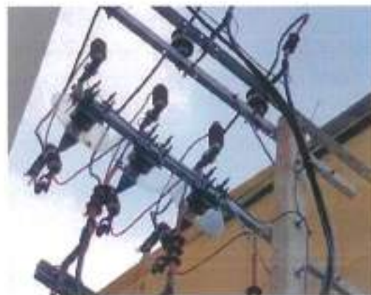
อุปกรณ์ป้องกันลัดกันแรงสูง : Lightning Arrester
