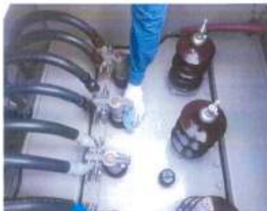
ทำความสะอาด Bushing ด้านแรงต่ำ
