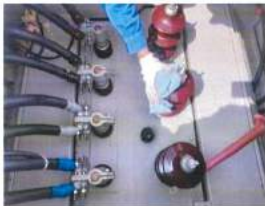
ทำตรวจสอบ Bushing ด้านแรงสูง
